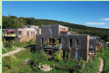
Siedlung BROT-Pressbaum. Foto: Andreas Scheurer
